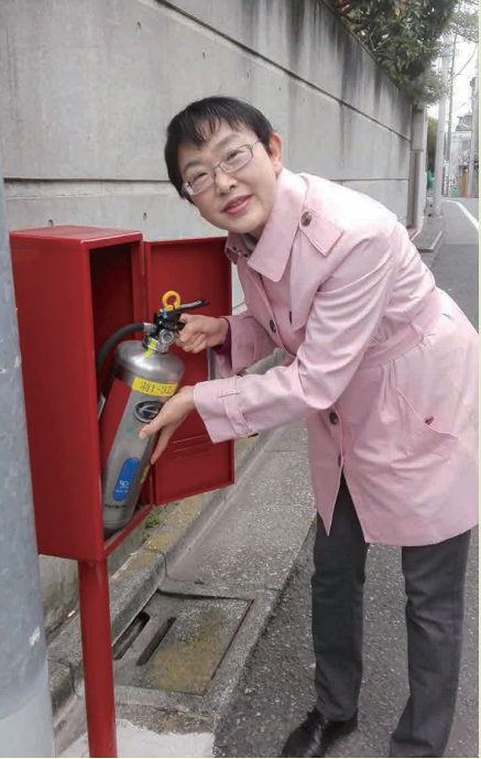
消火栓を手に取る高岡区議
