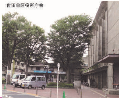
世田谷区役所庁舎
