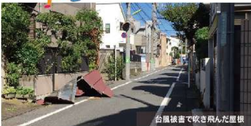
台風被害で吹き飛んだ屋根
