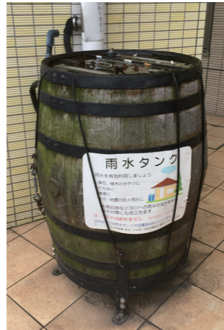
雨水タンク(雨水を貯蓄し再利用する)徳寺駅前
