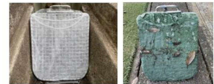
人工芝から出るマイクロプラスチックでびっしり詰まった集塵設備(右)。流出抑制は一部にとどまり、排水管を通じて海へ流れ出ます。多摩市「人工芝におけるマイクロプラスチック流出抑制対策ガイドライン」より
